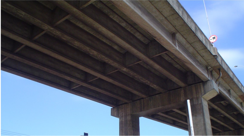
1 Figura 2: Vista inferior de uma ponte.
