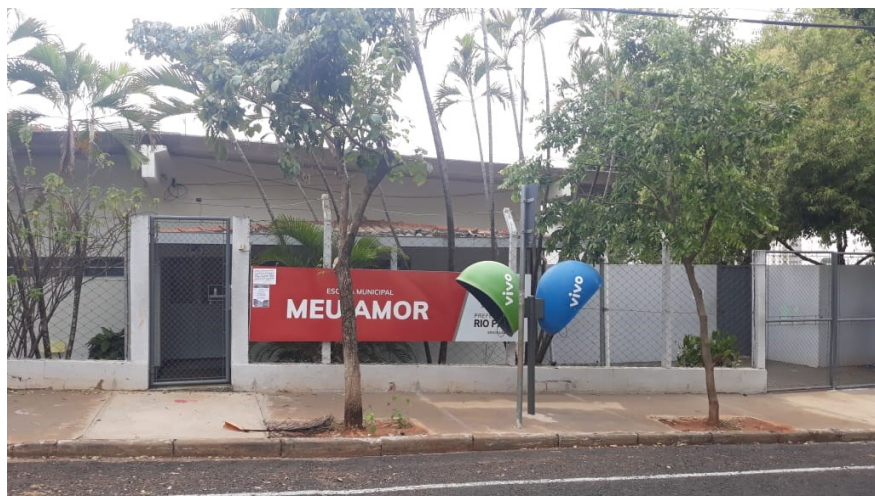
Figura 1 - Fachada da Escola Municipal Meu Amor – Unidade I
