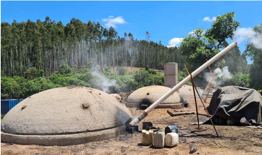
Figura 4. Instalação dos tubos coletores aos fornos.
