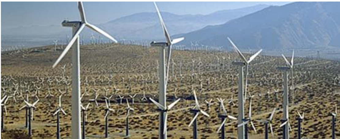
Figura 5 - Parque Eólico aos Arredores do Lago Turkana, Kenya [10]
