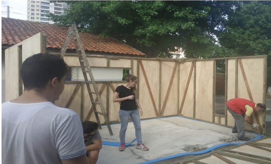
Figura 19 – Paredes externas da Tiny House sendo colocadas sobre o radier
