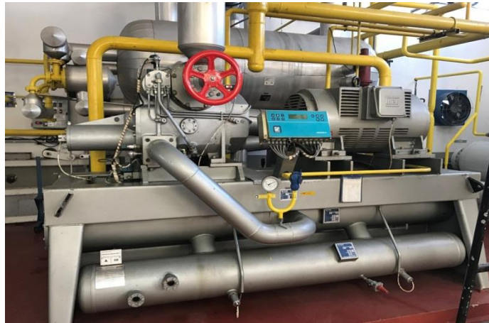
Figura 5 - Compressor de amônia tipo Parafuso
