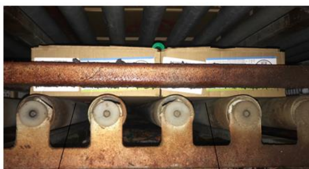
Abaulamento da base da caixa entre os rolos
