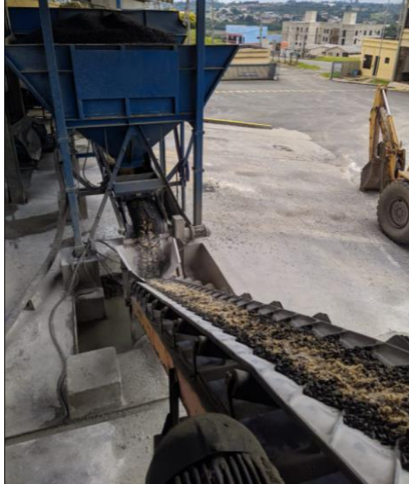
Figura 6 - Produção do concreto da empresa
