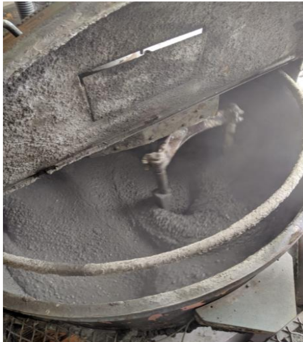
Figura 7 - Mistura do concreto na concreteira industrial
