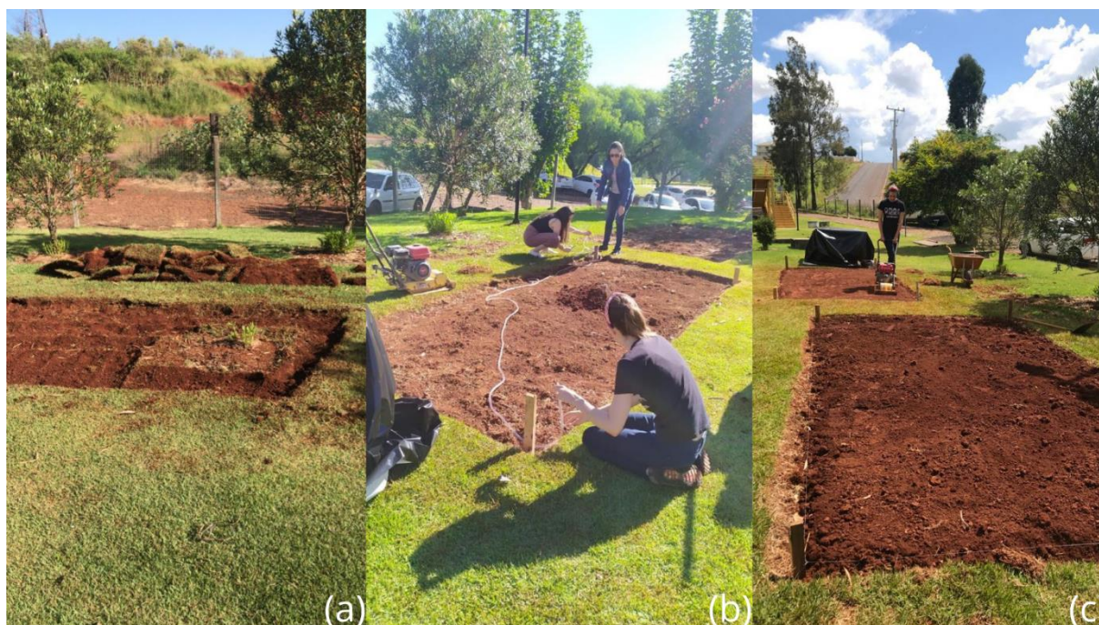
Figura 8 - Etapas da preparação do terreno: (a) Limpeza e escavação; (b) Nivelamento; (c) Compactação.
