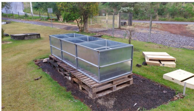
Figura 9 - Regularização da área, colocação de pallets e instalação do módulo experimental. Fonte: Acervo pessoal.
