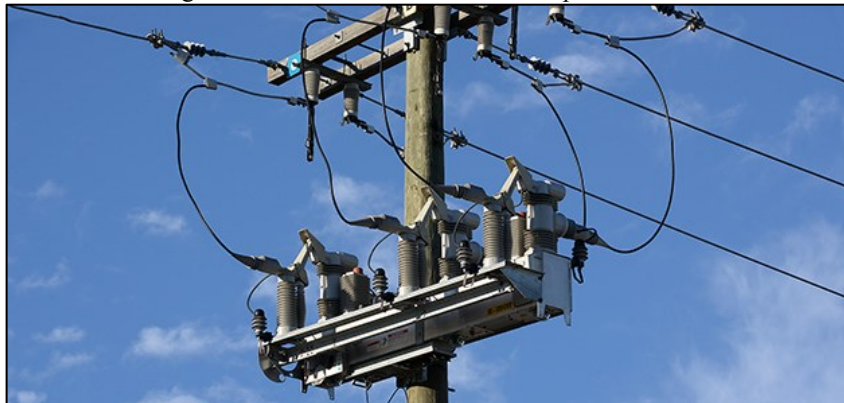
Figura 8 - Detector de falhas IntelliRupter da S&C
