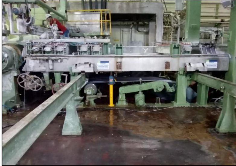
Figura 29 - Imagem do posicionamento dos trilhos para suportaço da mesa plana durante a manutenço
