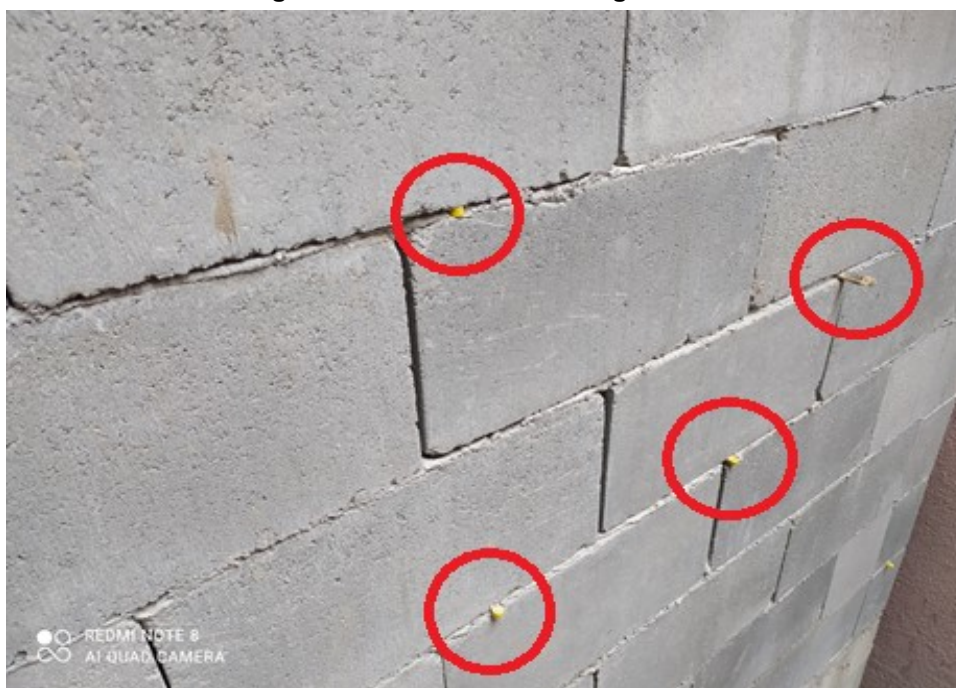
Figura 17 - Controle altura argamassa
