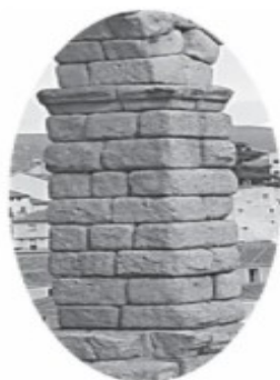
Figura 1 - Amarrações nas diferentes fiadas
