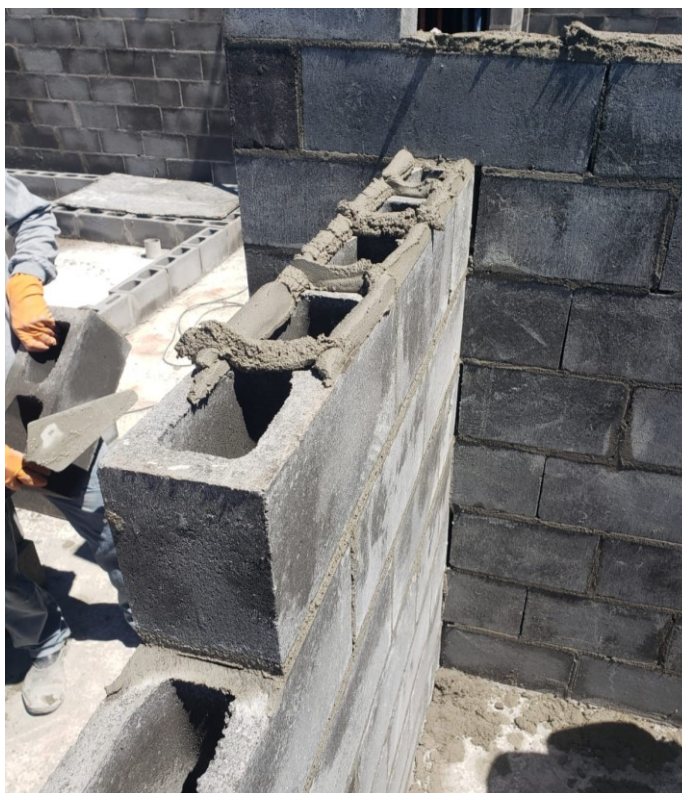
Figura 18 - Aplicação em todas paredes dos blocos
