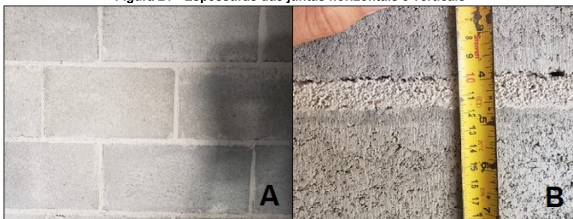
Figura 21 - Espessuras das juntas horizontais e verticais
