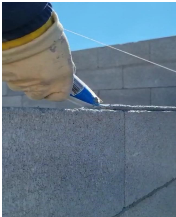
Figura 14 - Aplicação argamassa polimérica
