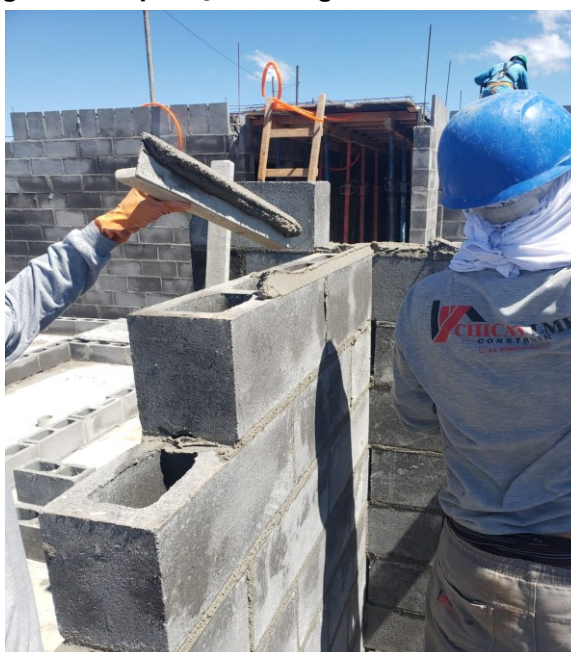
Figura 15 - Aplicação da argamassa convencional
