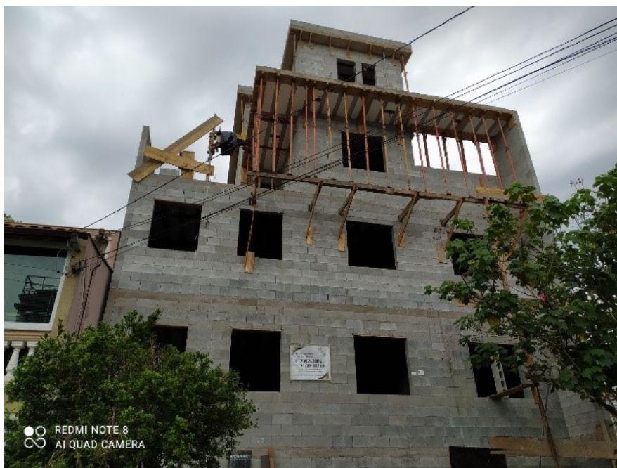
Figura 11 - Obra em execução com argamassa polimérica
