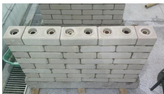
Figura 14 - Vista lateral da parede (P 2) Fonte: Autoria própria (2016)
