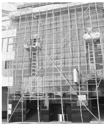
Figura 2 - Andaim de Bambu em Única Camada - Single Layered Bamboo Scaffolds (SLBS)
