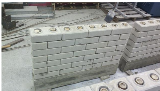
Figura 56 – Colmos de bambu com o diafragma na extremidade, colocados no interior dos furos dos blocos nas paredes. Fonte: Autoria própria
