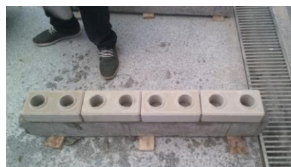
Figura 17 - Fiada inicial com blocos De solo-cimento (P 1) Fonte: Autoria própria (2016)
