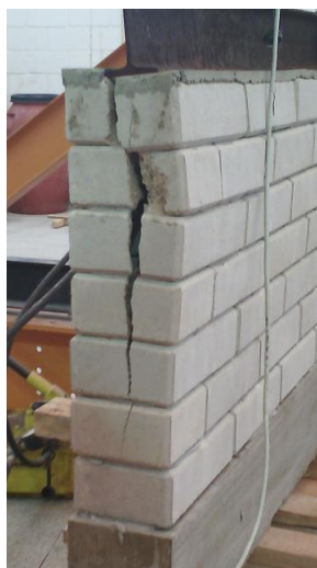
Figura 59 - CP 1 após rompimento no ensaio à compressão Fonte: Autoria própria
