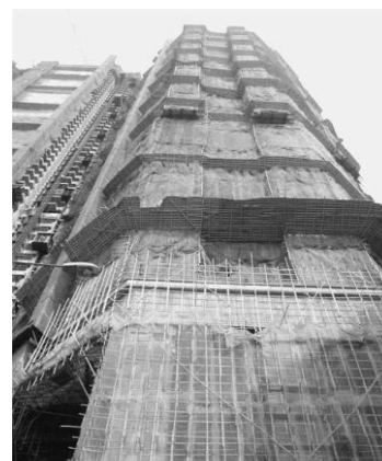
Figura 3 - Andaim de Bambu em Dupla Camada - Double Layered Bamboo Scaffolds (DLBS)
