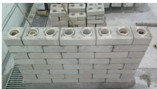
Figura 12 - Vista lateral da parede (P 1) Fonte: Autoria própria (2016)
