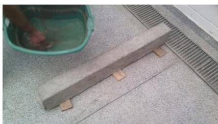
Figura 16 - Viga em concreto para assentamento sendo umedecida Fonte: Autoria própria (2016)
