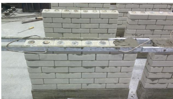
Figura 57 – CP recebendo capeamento e regularização para apoio. Fonte: Autoria própria
