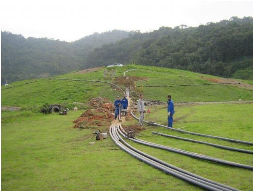
Figura 19 - Implantação de tubulações para condução do biogás.
