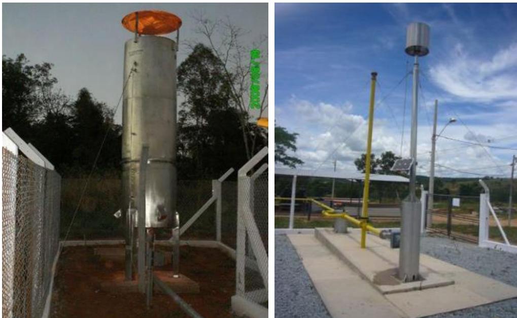
Figura 20a- Queimador flare tipo fechado. Figura 20b – Queimador flare tipo aberto.
