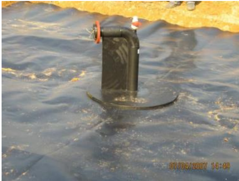
Figura 18 - Instalação de cabeçote no aterro sanitário.
