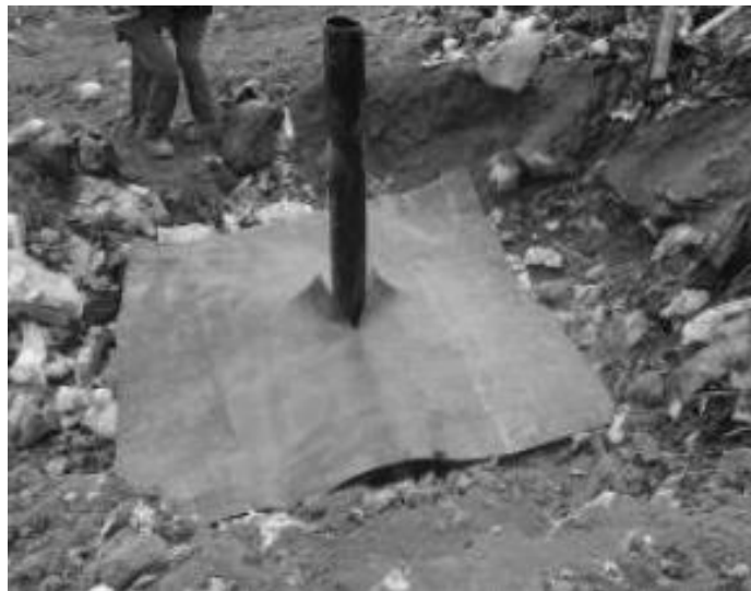
Figura 14 - Geomembrana no dreno vertical
