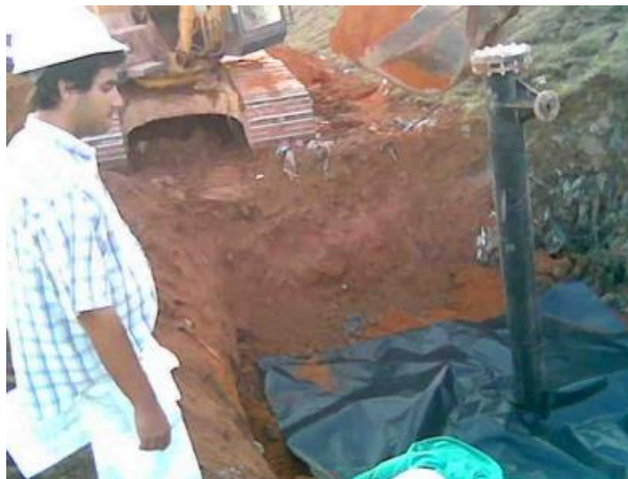
Figura 17 - Vista de instalação da Manta PEAD
