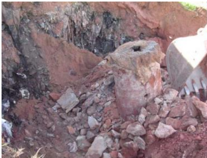
Figura 13 - Vista da escavação de dreno vertical
