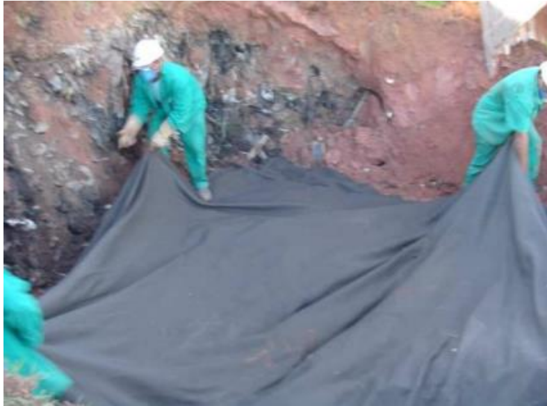
Figura 16 – Vista de instalação da Manta geotêxtil.
