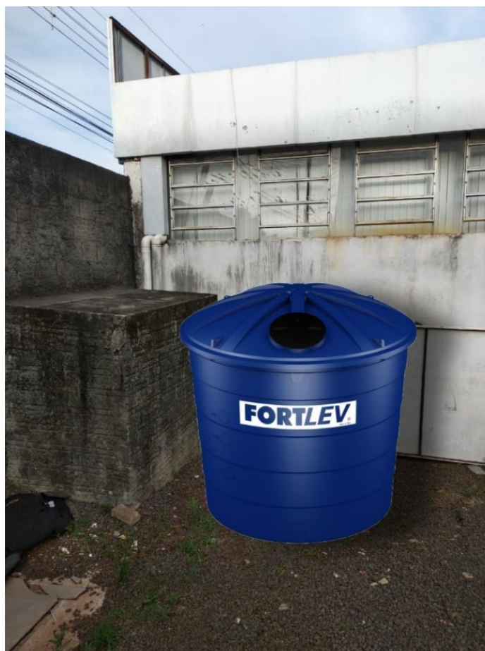
Figura 20 - Local de instalação da cisterna
