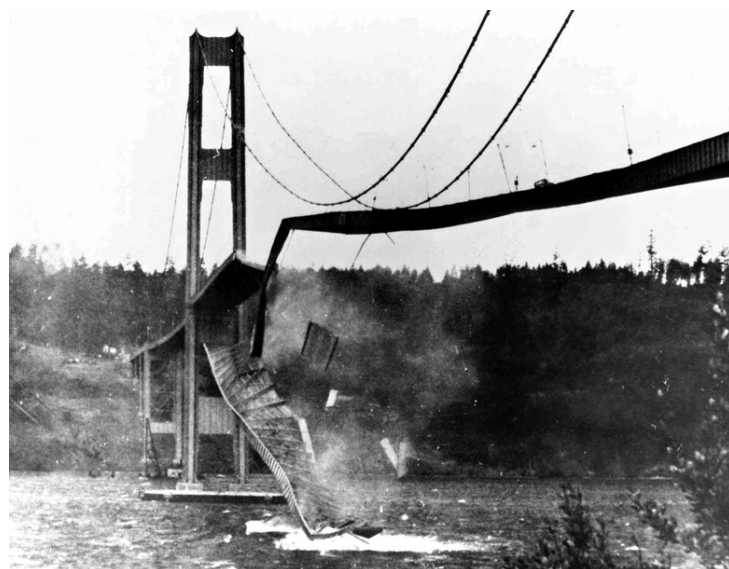
Figura 1 – Colapso da ponte de Tacoma
