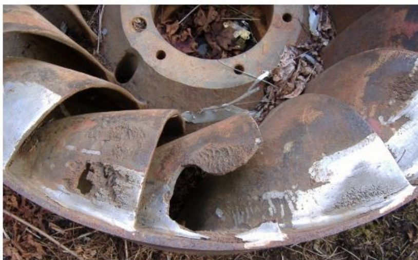
Figura 4 – Danos das pás de uma turbina Francis causado por cavitação.
