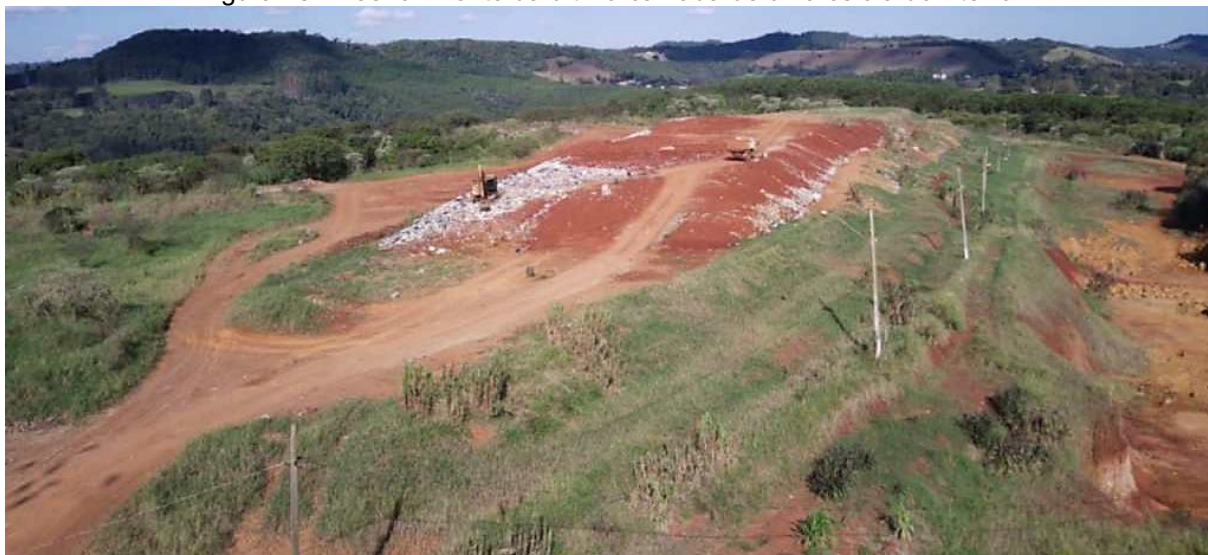
Figura 18: Preenchimento da última camada de uma célula do Aterro.
