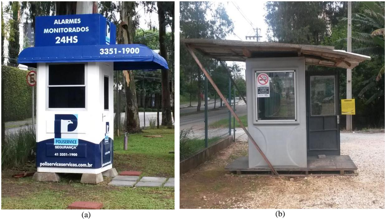
**Figura 11 – Exemplos de adaptações na cobertura nas guaritas de fibra de vidro (a) no estacionamento de um shopping (Mercadoteka) e (b) no estacionamento da Universidade Tecnológica Federal do Paraná**
