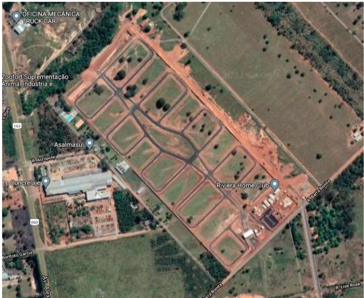
Figura 3 - Imagem aérea do empreendimento
