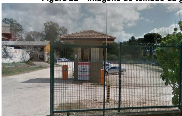
22a – Cobertura em 2020 Fonte: Autor (2020)
