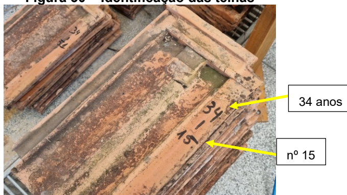
Figura 30 – Identificação das telhas
