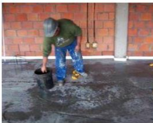
Figura 8: Umedecimento superficial do substrato
