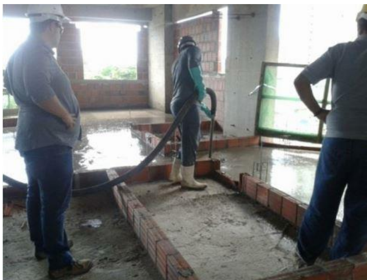
Figura 5: Isolamento com bloco cerâmico em área com desnível
