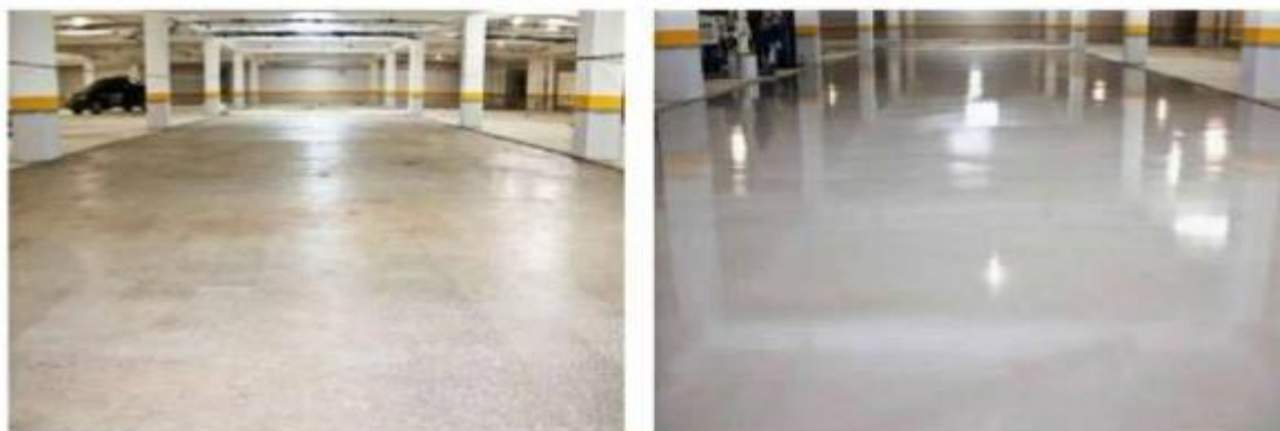
Figura 2: Área de estacionamento antes e depois da aplicação do contrapiso autonivelante industrial
