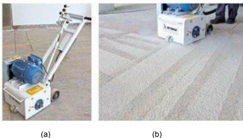
Figura 6: Tratamento superficial do substrato para receber a argamassa autonivelante: (a) Máquina fresadora; (b) Aparência da laje após fresamento
