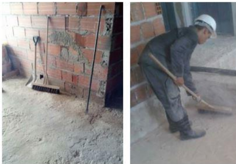
Figura 4: (a) Utensílios utilizados para a limpeza do substrato; (b) Substrato sendo varrido com vassourão
