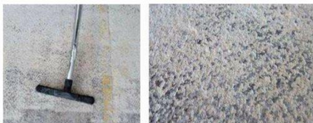
Figura 7: (a) Aplicação do primer; (b) Aparência da laje após aplicação do primer
