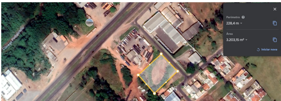
Figura 38 - Terreno da Ecogenie
