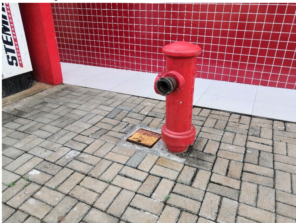
Fotografia 3 - Hidrante de coluna na sede do 10º GB
