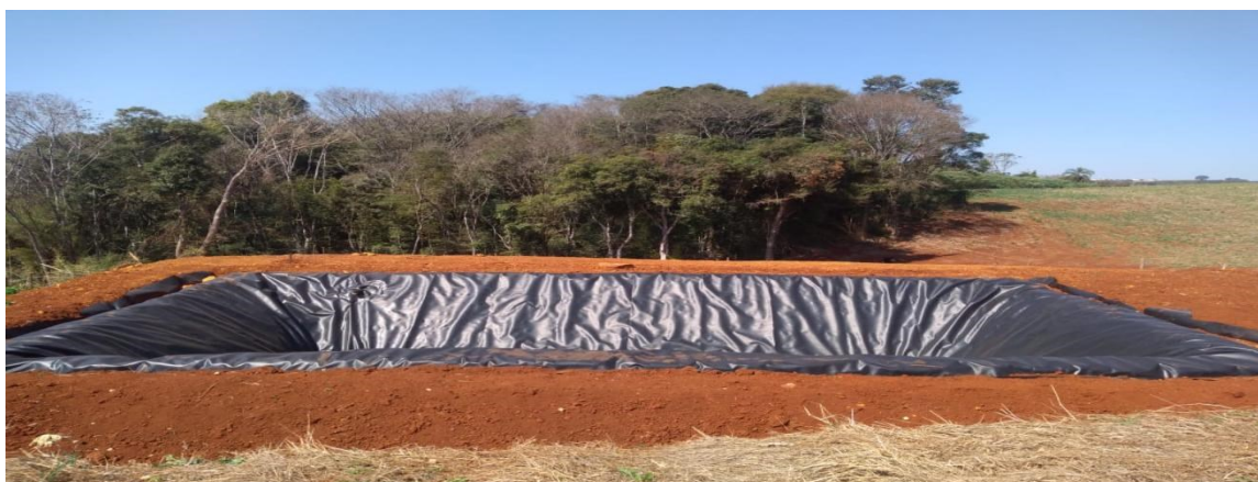
Figura 05 - Estrutura e localização da Lagoa 1 de tratamento da indústria de laticínio.
