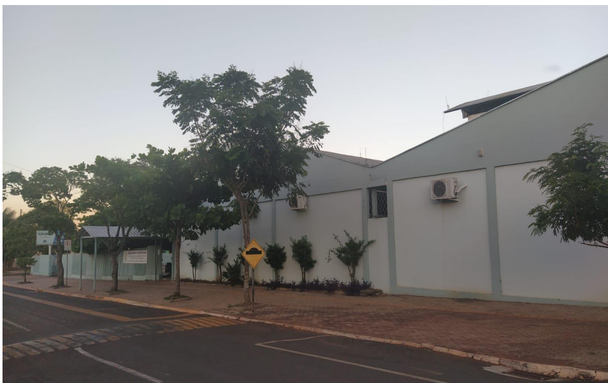
Figura 6: Fachada da Escola Municipal Tancredo Neves
