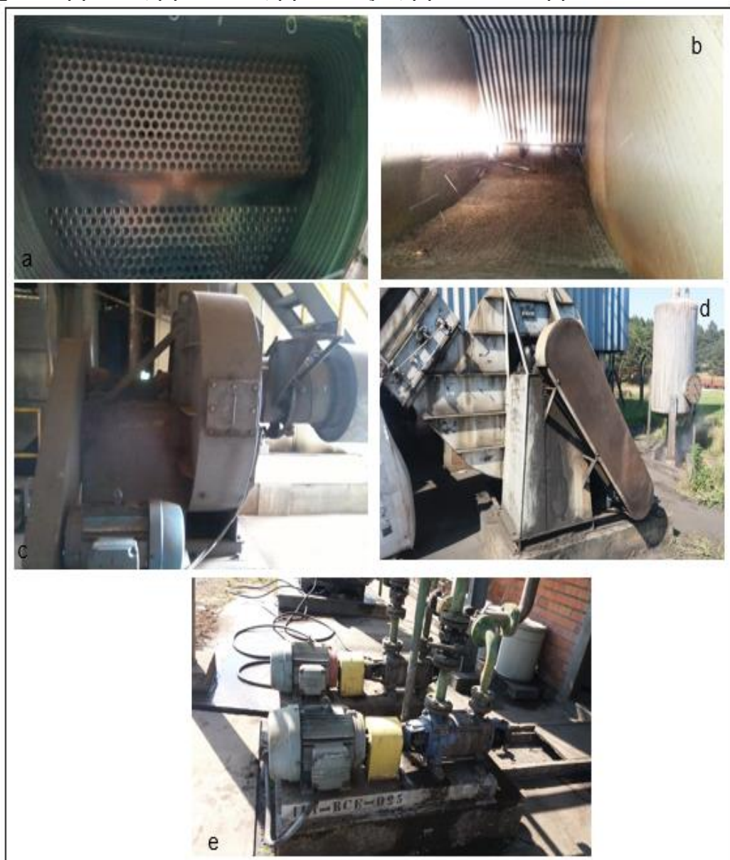
Figura 6. (a) Balão, (b) Fornalha, (c) Ventilação, (d) Exaustão e (e) Abastecimento de água
