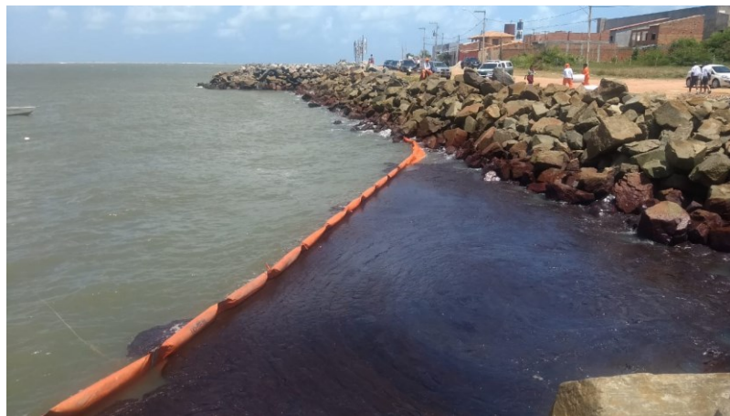
Figura 14: Barreiras de contenção
