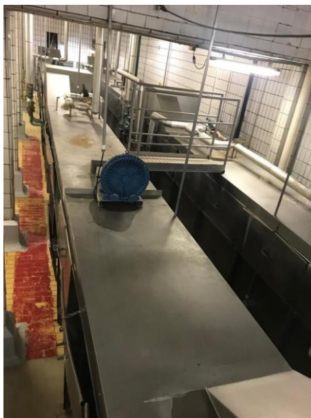
Figura 11 —Tanque de escaldagem. Sudoeste do Paraná, 2018. Fonte: O autor, (2018).
