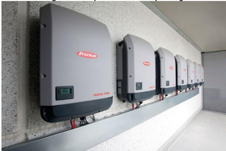
Figura 8 - Exemplo de inversor do tipo String
