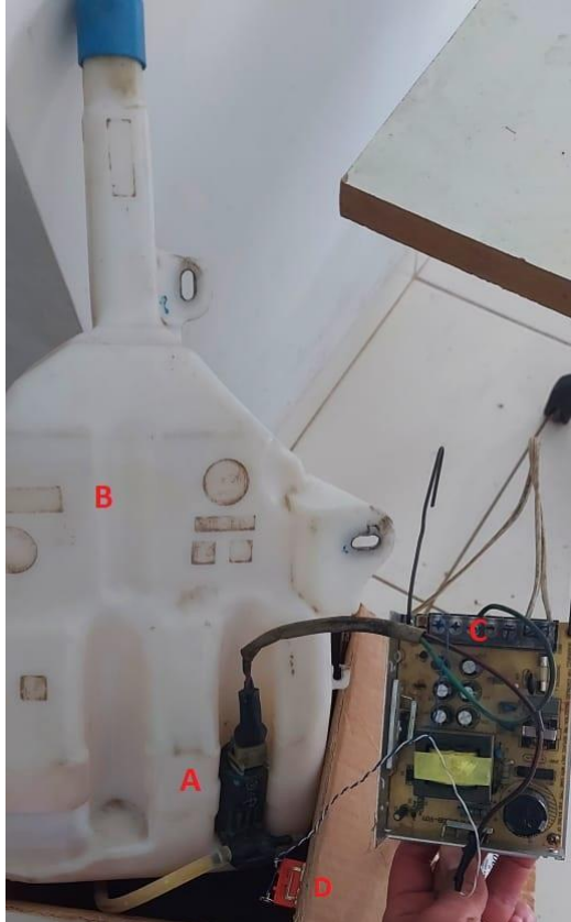
Fotografia 3 – Sistema de refrigeração
