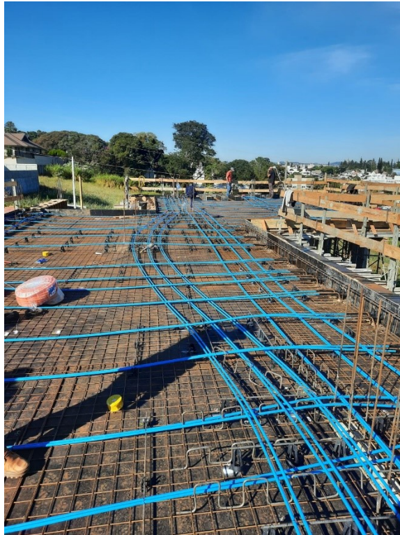
Figura 11 - Execução de laje com protensão não aderente
