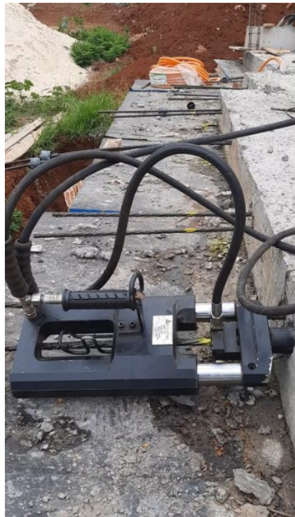
Figura 8 - Tracionamento das cordoalhas com macaco de protensão
