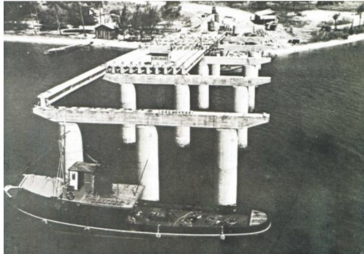
Figura 2 - Construção da Ponte do Galeão
