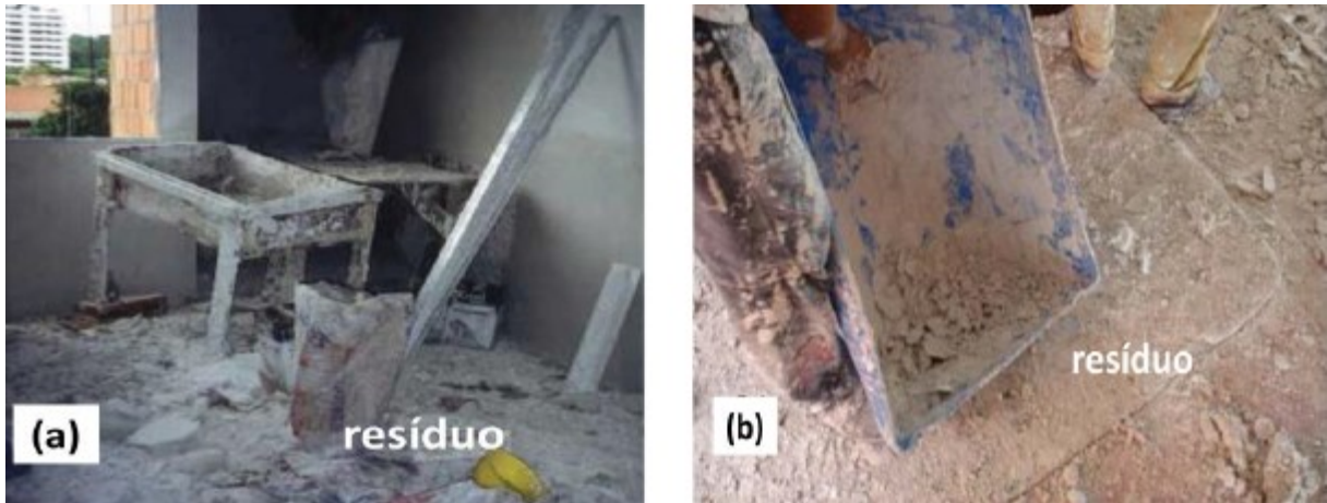
Figura 17: Geração de resíduos na execução de revestimento com pasta de gesso
