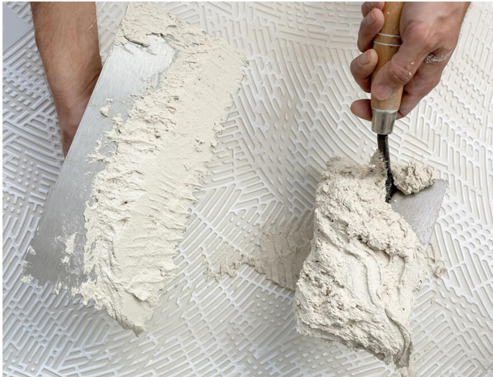
Figura 9: Aplicação do gesso na construção civil - revestimento
