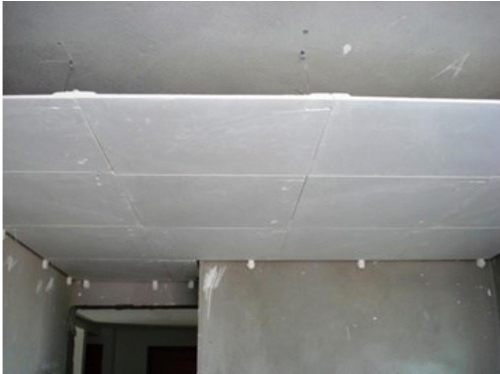
Figura 7: Aplicação do gesso na construção civil - rebaixamento de forro
