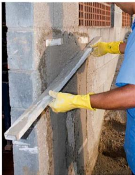
Figura 12: Sarrafeamento do emboço
