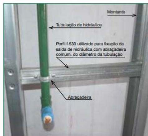
Figura 26: Instalações hidráulicas no drywall
