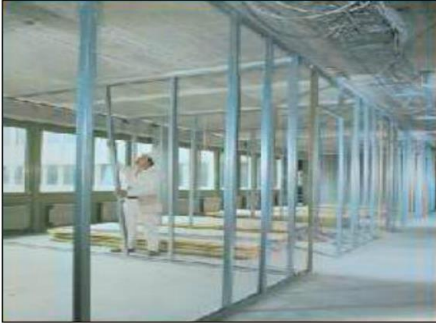
Figura 21: Marcação e fixação das guias
