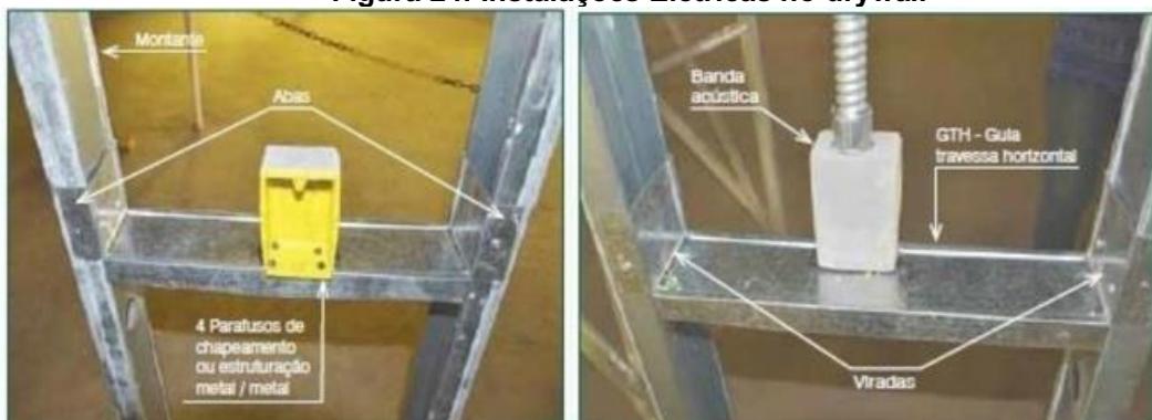
Figura 24: Instalações Elétricas no drywall
