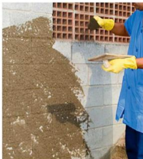
Figura 11: Aplicação do chapisco
