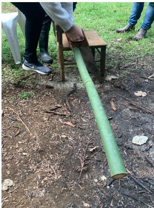
Figura 12- Corte das peças de bambu Fonte: Autoria própria (2022)
