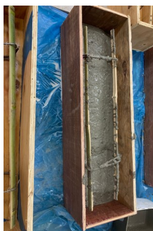
Figura 22- Concretagem de 1/3 da fôrma Fonte: Autoria própria (2022)
