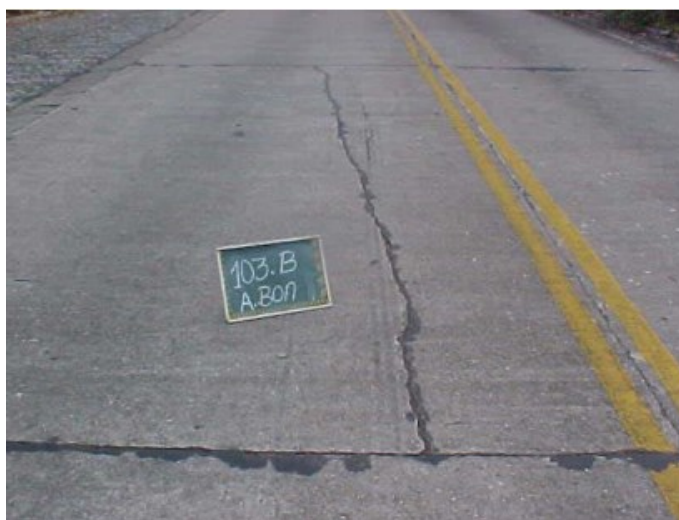
Figura 2: Trincas Longitudinais
