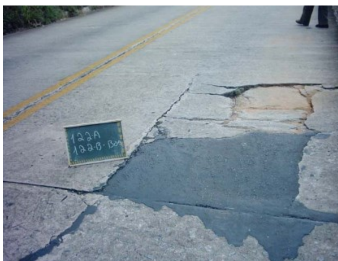
Figura 3: Ocorrência de erosão
