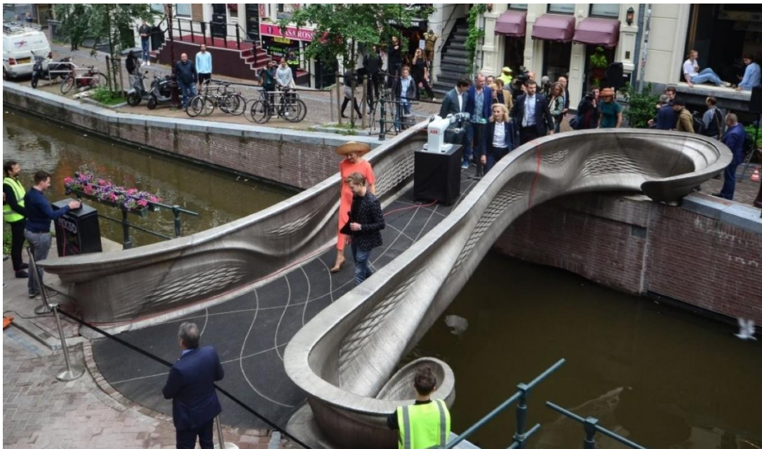
Figura 2 - Primeira ponte confeccionada por MA e design generativo.
