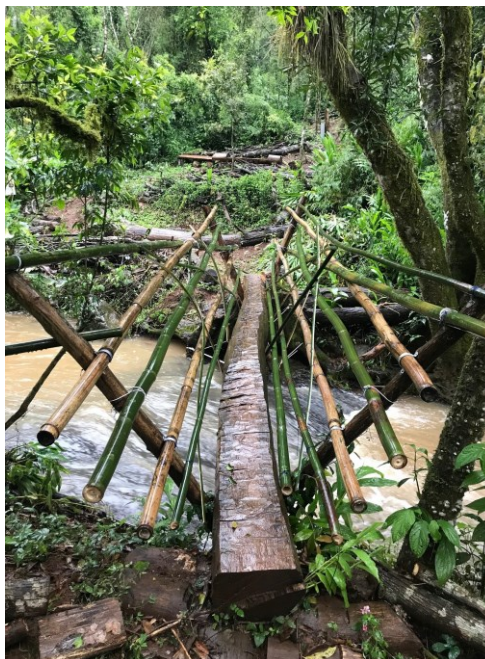
Figura 20 - “Pinguela” de acesso construída com madeira de uva-do-japão e taquara
