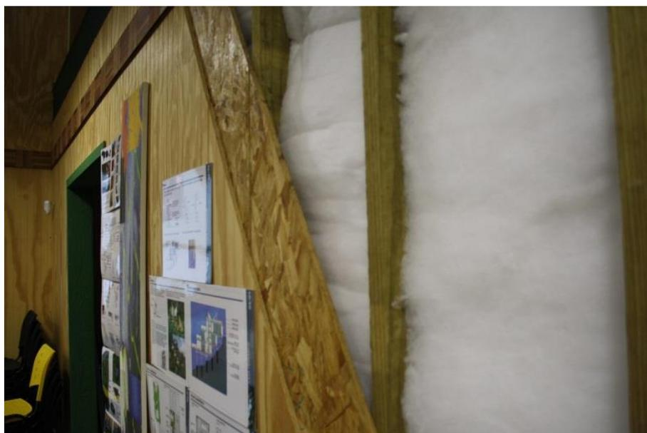
Figura 12 – Parede demonstrativa da estrutura interna. Painéis OSB e montantes em *Pinus taeda*
