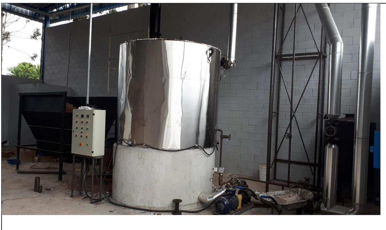
**Fig. 10 - Aquecedor de óleo térmico instalado.**
