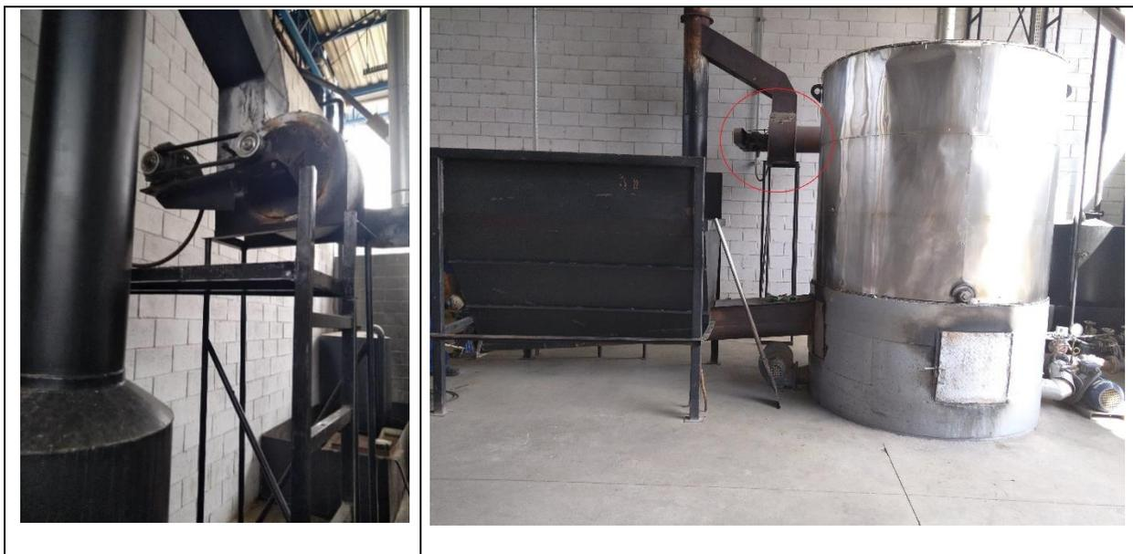
**Fig. 16 – Motor do exaustor para chaminé.
