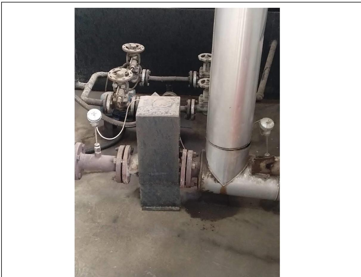
**Fig. 12 – Bomba de Engrenagem.**
