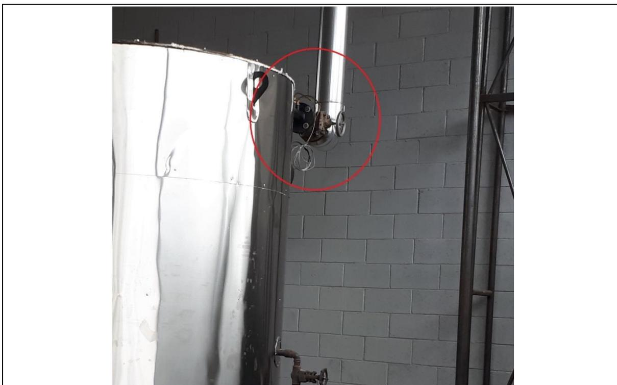
**Fig. 17 – Termopares tipo J na saída do aquecedor de óleo térmico.
