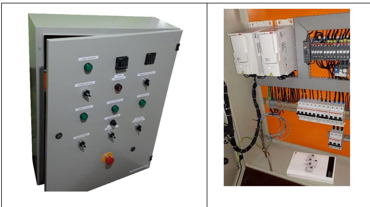
**Fig. 11 – Quadros de comando do aquecedor de óleo térmico.**
