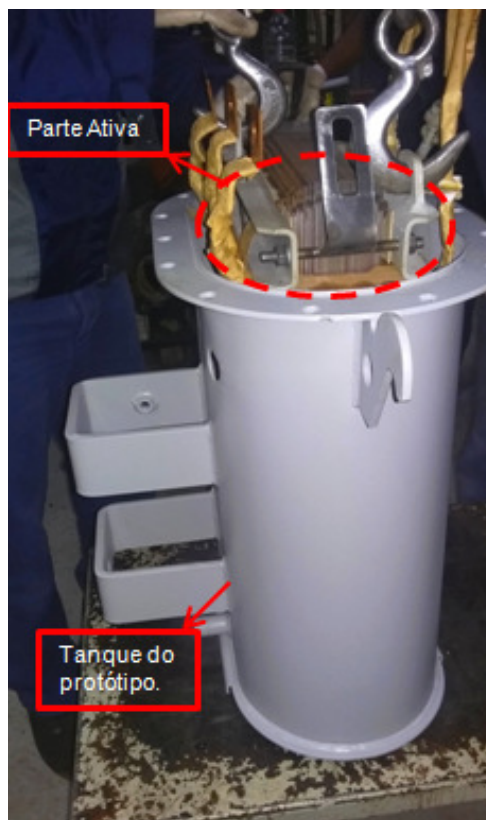
Figura 31 – içamento da parte ativa. Fonte: Autoria própria.
