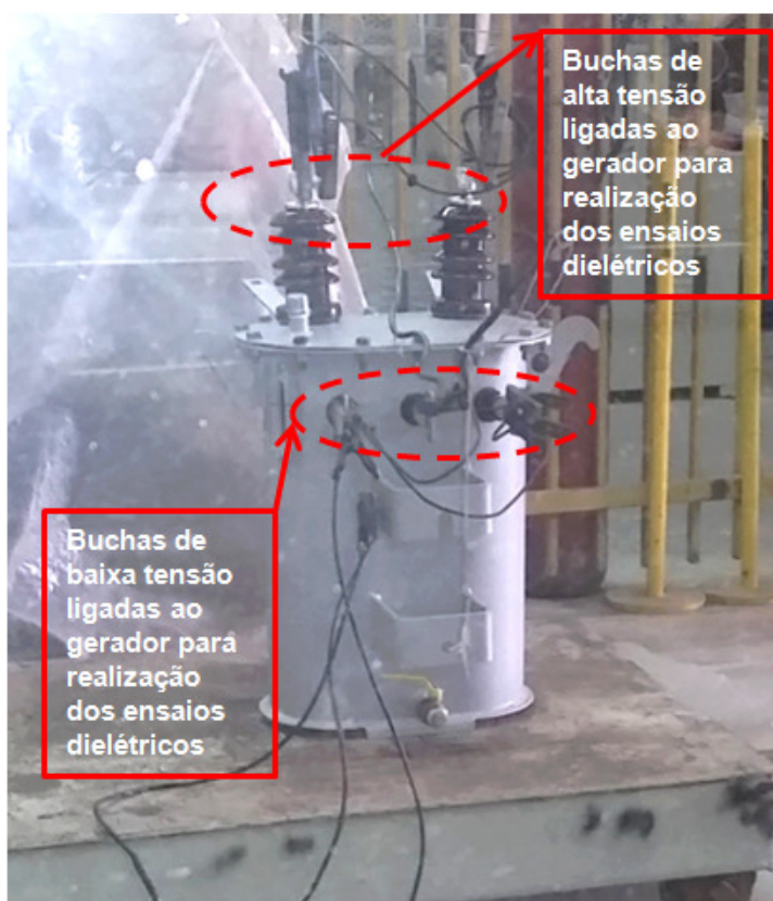
Figura 34 – Circuito para ensaios dielétricos. Fonte: Autoria própria.
