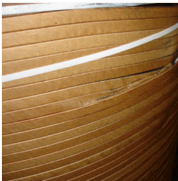
Figura 3 – Detalhe do enrolamento tipo “camada” com fio retangular.
