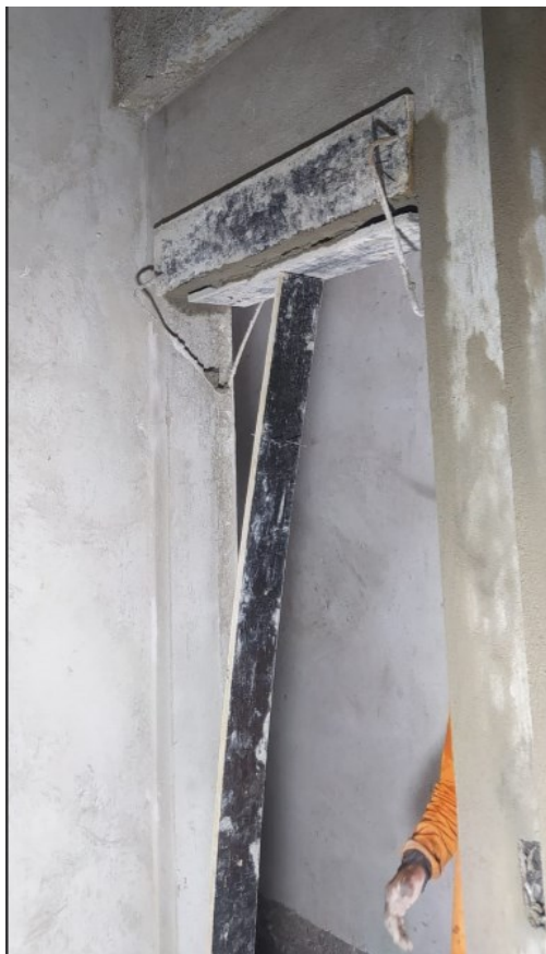
Figura 9 – Parede iluminada com auxílio de holofote de led
