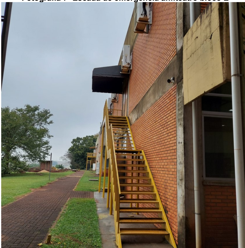
Fotografia 7 -Escada de emergência anfiteatro bloco E
