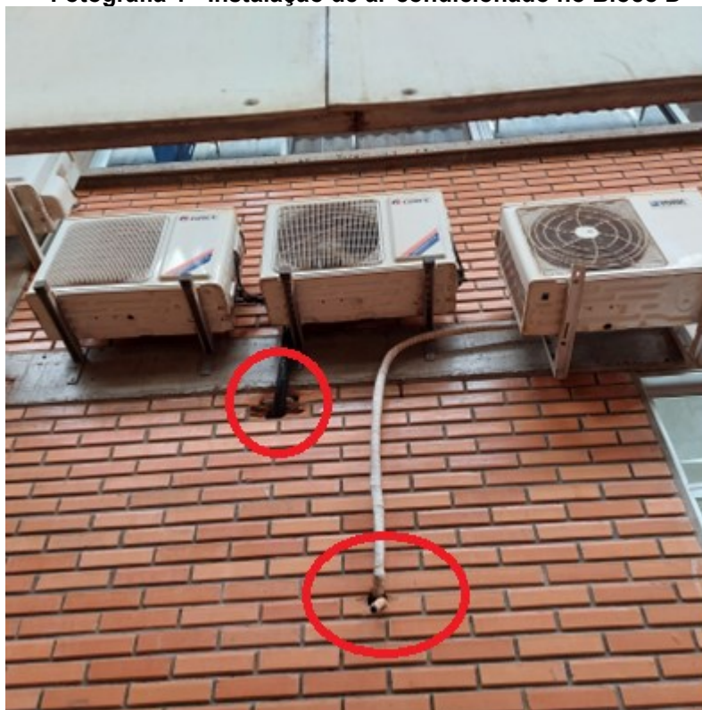
Fotografia 1 - Instalação de ar-condicionado no Bloco D
