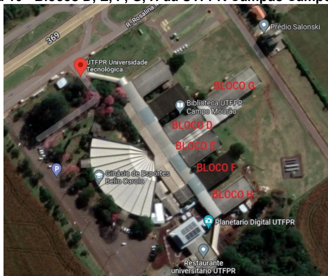
Figura 10 - Blocos D, E, F, G, H da UTFPR Campus Campo Mourão
