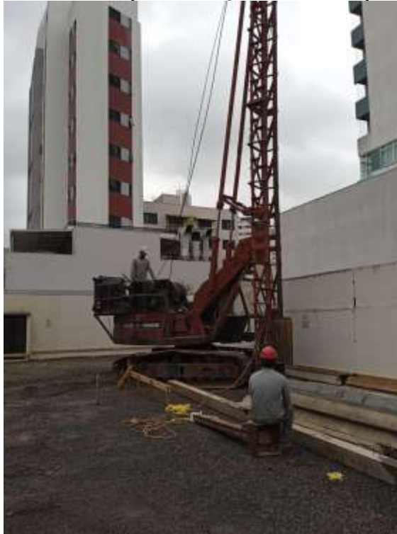
Figura 11: Bate estacas para cravação de estacas pré-moldadas
