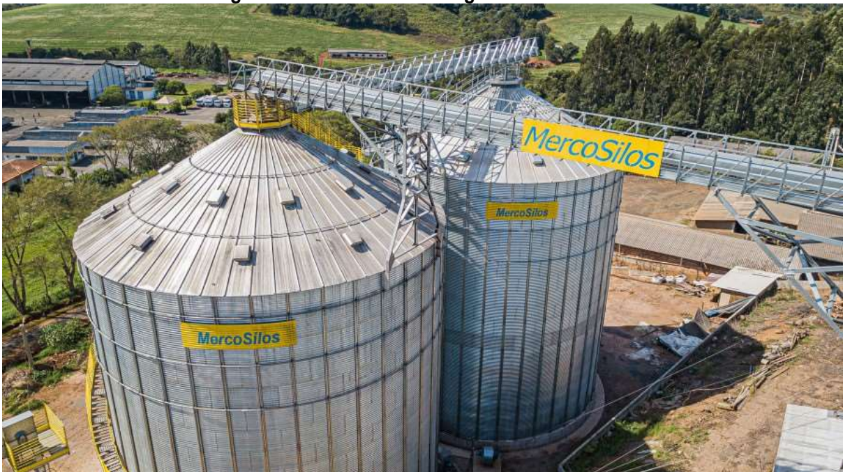
Figura 13:Obra de armazenagem da Mercosilos
