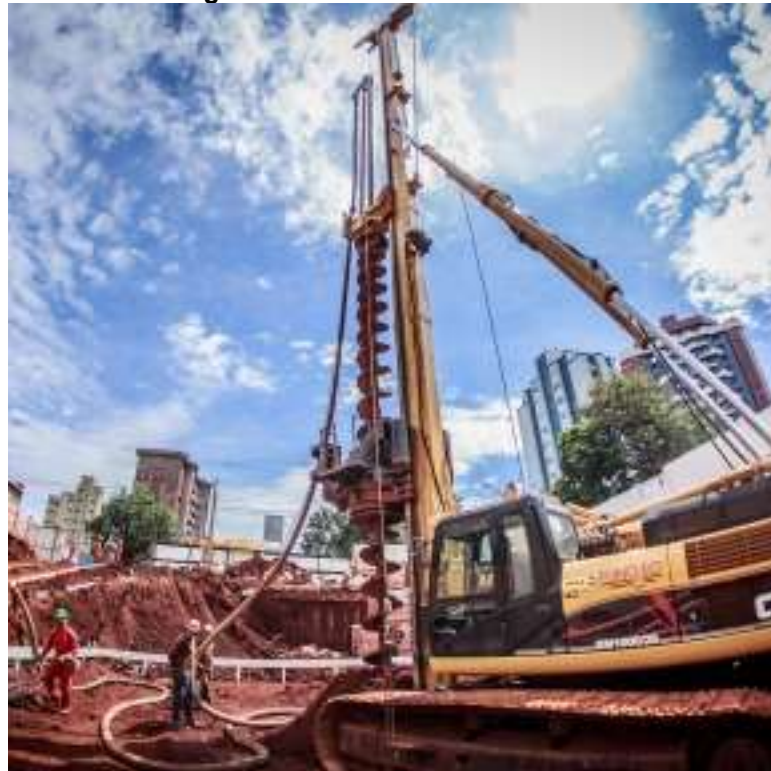
Figura 10: Estacas hélice contínua
