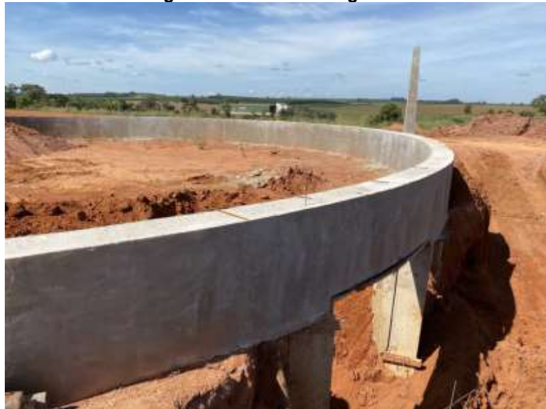
Figura 14: Detalhe da viga anel
