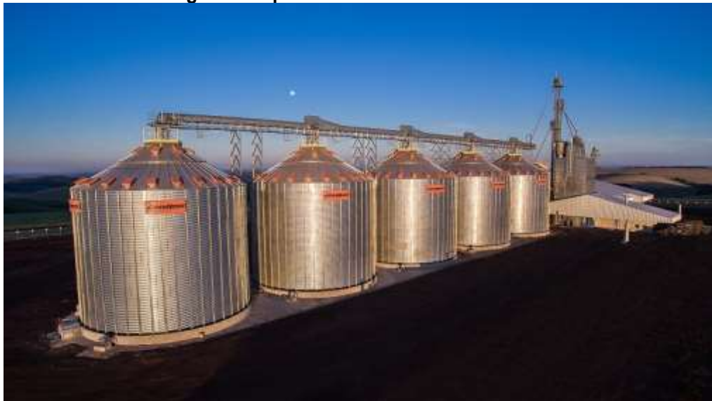
Figura 4:Superestrutura de silos metálicos
