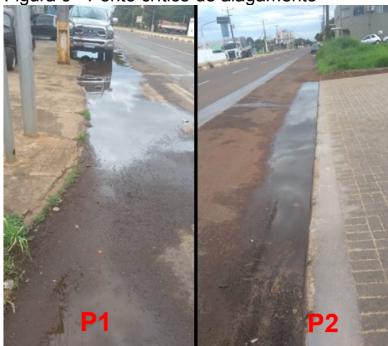
Figura 9 - Ponto crítico de alagamento
