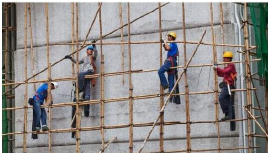
Figura 8 - Andaime de bambu de camada simples
