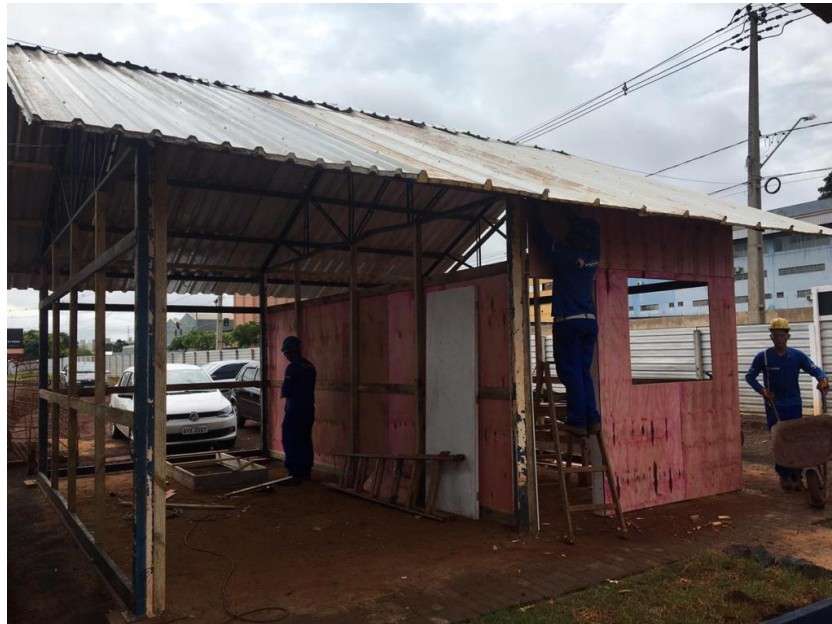
Figura 8. Montagem da sala de engenharia, TST, mestre de obras e encarregados.
