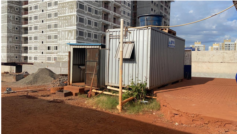
Figura 20. Banheiros dos colaboradores.
