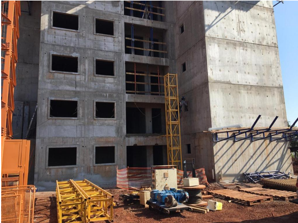
Figura 24. Instalação da cremalheira.
