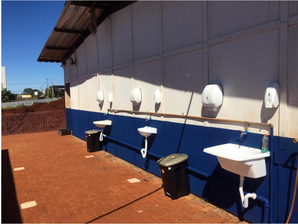
Figura 11. Pontos de higienização ao lado dos banheiros.
