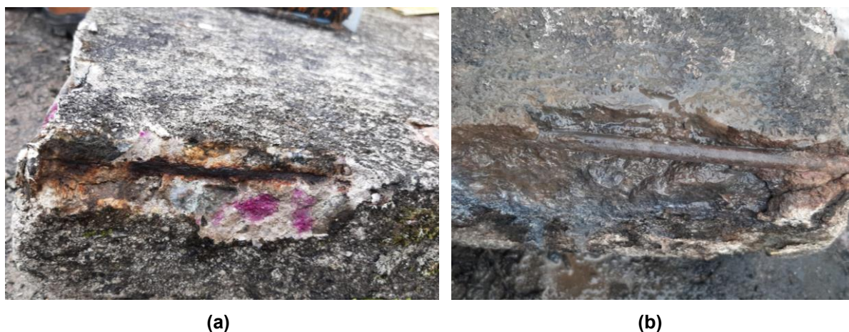
Figura 14 - Processo de Ataque por Íons cloreto.
