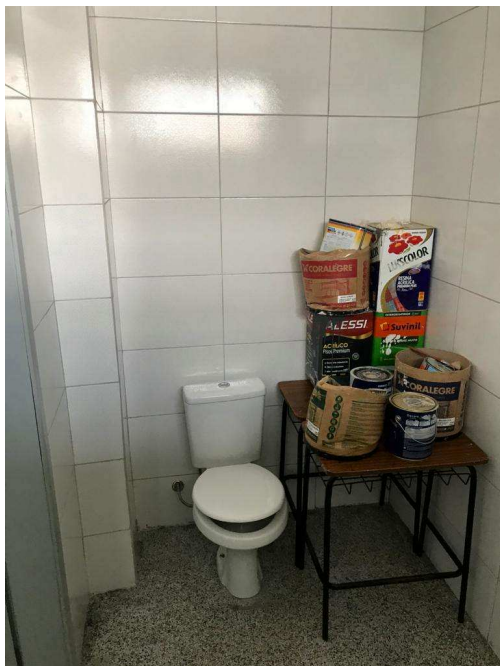
Figura 16 – Sanitário do banheiro acessível.
