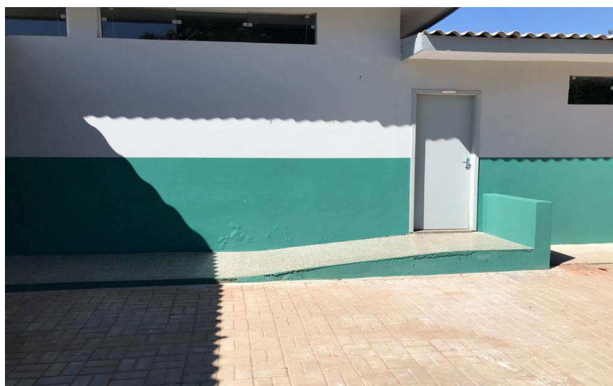
Figura 14 – Rampa que dá acesso a biblioteca.
