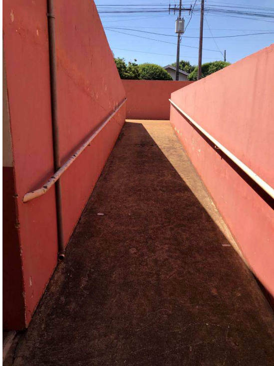
Figura 24 – Primeiro lance da rampa que dá acesso ao segundo andar.
