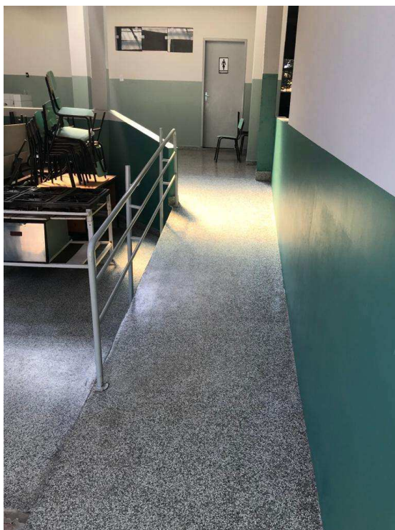
Figura 15 – Rampa mais longa que dá acesso a biblioteca.
