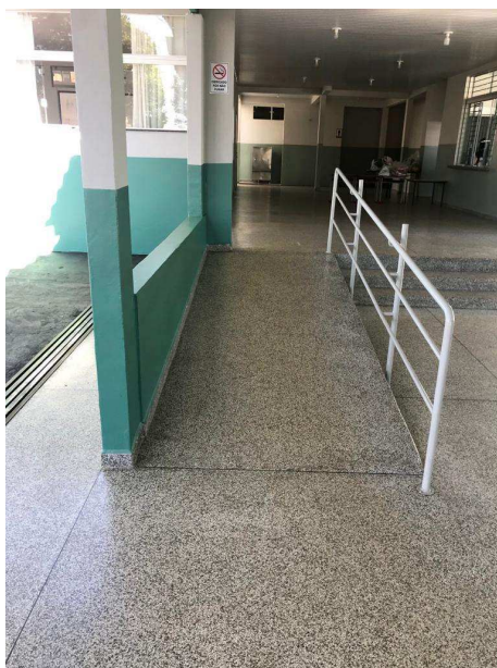
Figura 11 – Rampa da circulação principal da escola.
