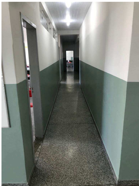
Figura 19 – Circulação que dá acesso as salas de aula.
