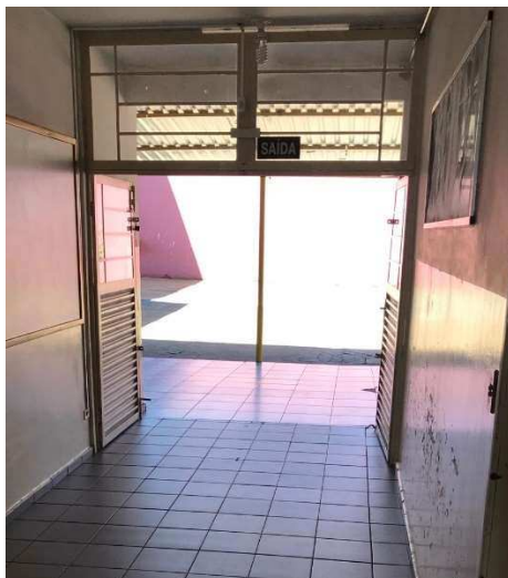
Figura 33 – Porta de saída para o pátio externo.
