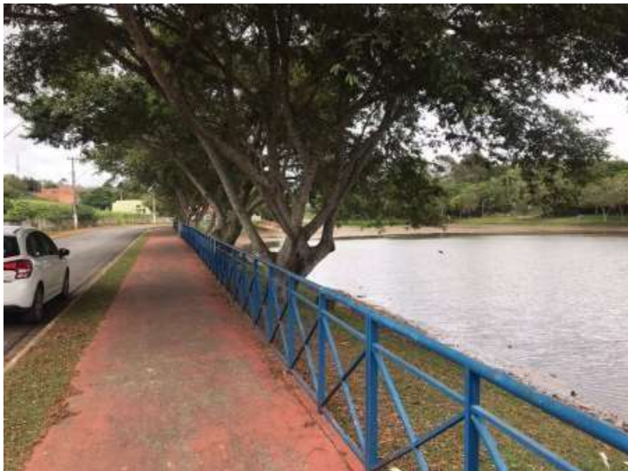
Fotografia 8: Trecho da Rua Marginal Fadel Jabur
