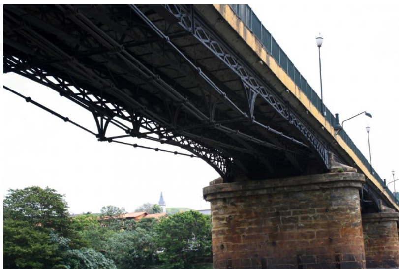
Figura 2 – Detalhe do meio do vão dos arcos da ponte sobre o rio Paraíba do Sul.
